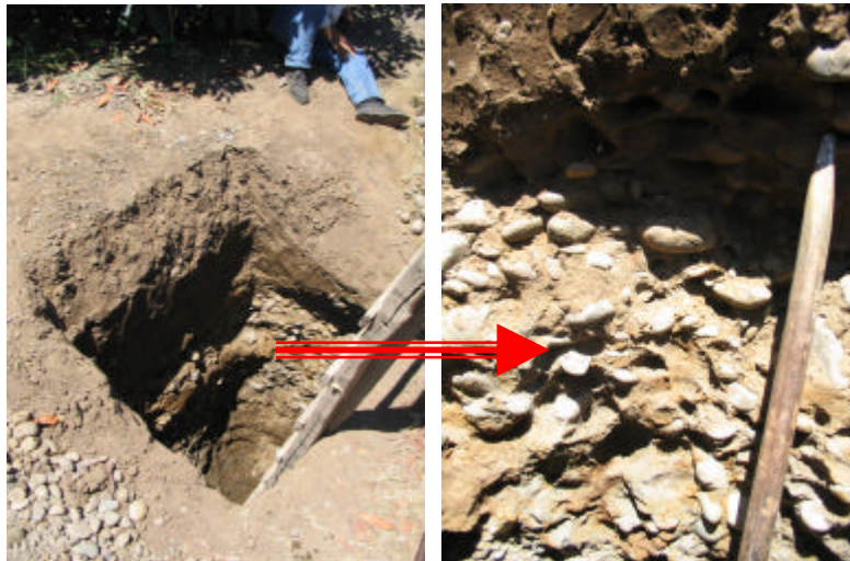
Foto 2. Calicata efectuada para conocer las características del suelo en la zona del Proyecto Fondef D02I-1146.
