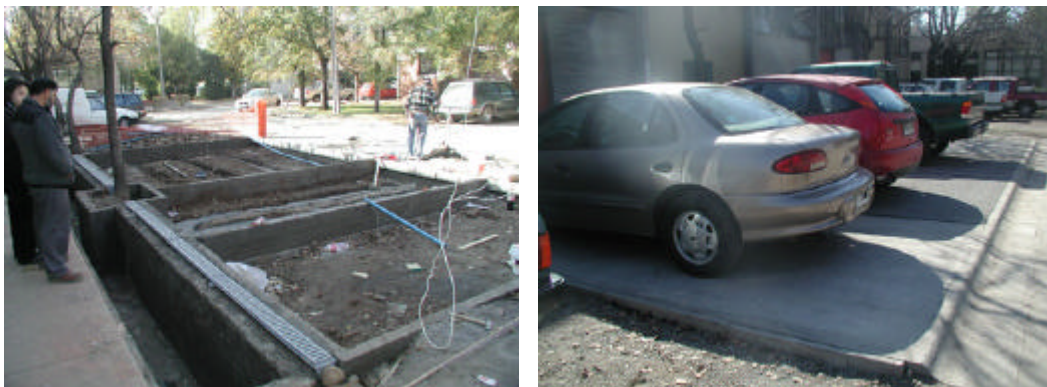
Figura 2. Fotos de la construcción.
