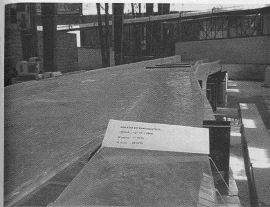
Foto 1: Proyecto Original Ensayo D-72-25
