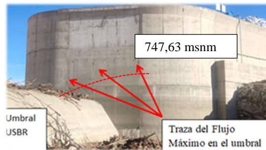
Figura N° 4: Traza del flujo máximo en muro lateral del umbral USBR
