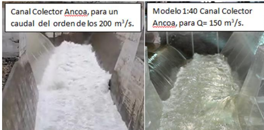
Figura N° 6: Comparación de las características del flujo entre el canal colector real (26-06-2023) y el modelo a escala reducida 1:40 (DOH-INH, 2015), para caudales comparables.
