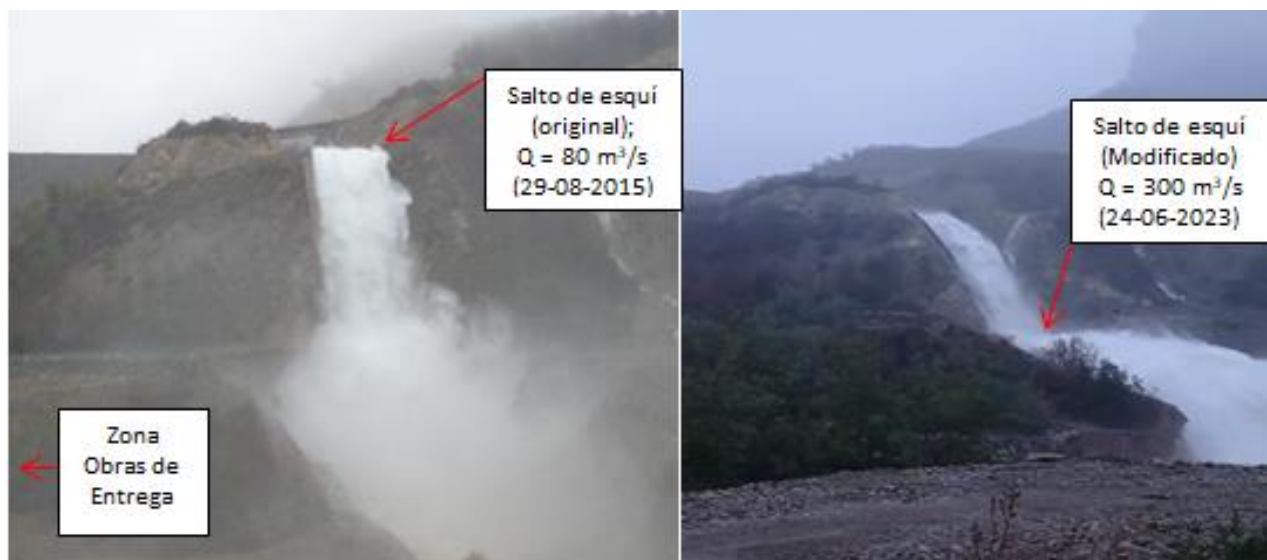
Figura N° 7: Comparación entre el vertimiento de 29-08-2015 con un caudal de 80 \text{ m}^3/\text{s} y el vertimiento del 24-06-2023, con un caudal estimado del orden de 300 \text{ m}^3/\text{s} .
