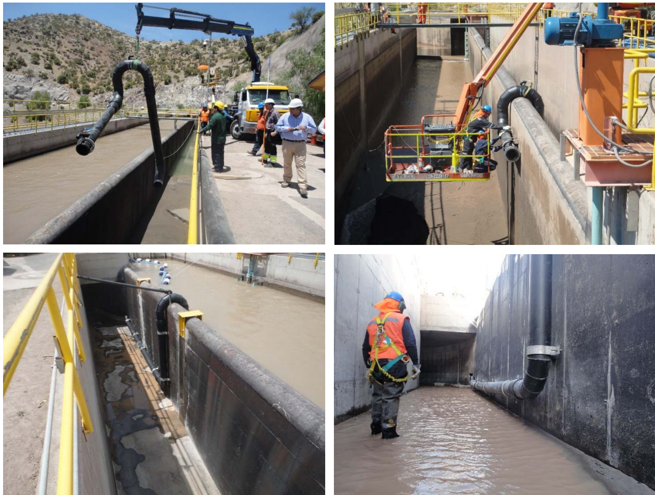
Figura 6. Instalación del sifón en cámara de carga Chacabuquito
