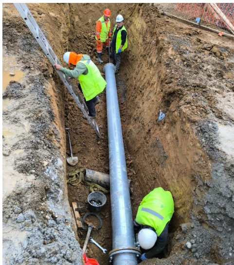
Figura 2: Instalación de red de agua potable en Chile.
