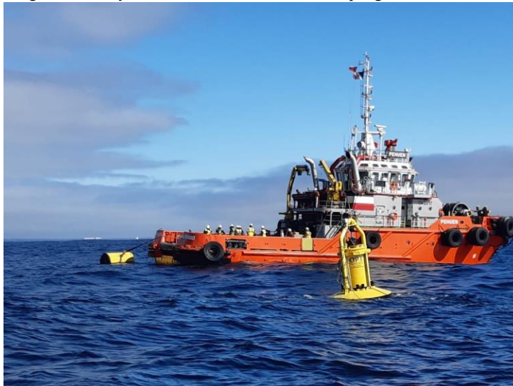
Figura 9. La boya PB3 en posición vertical, lista para generar energía a partir del oleaje.
