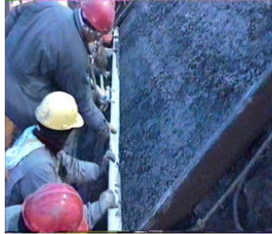
Foto 2 Alisado con regla vibratoria
