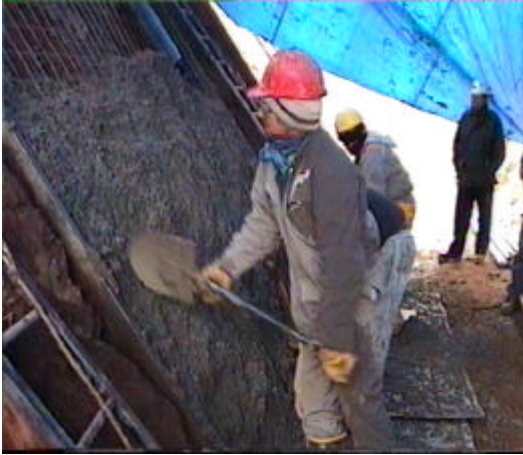
Foto 1 Hormigón lanzado manualmente con pala
