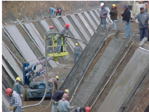
Foto 3 Construcción mediante hormigón proyectado
