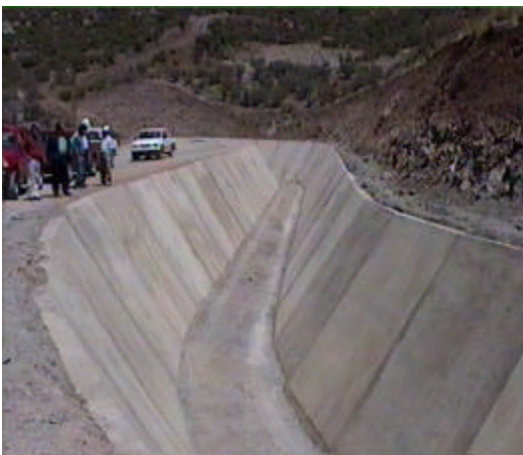
Foto 4 Tramo de canal terminado
