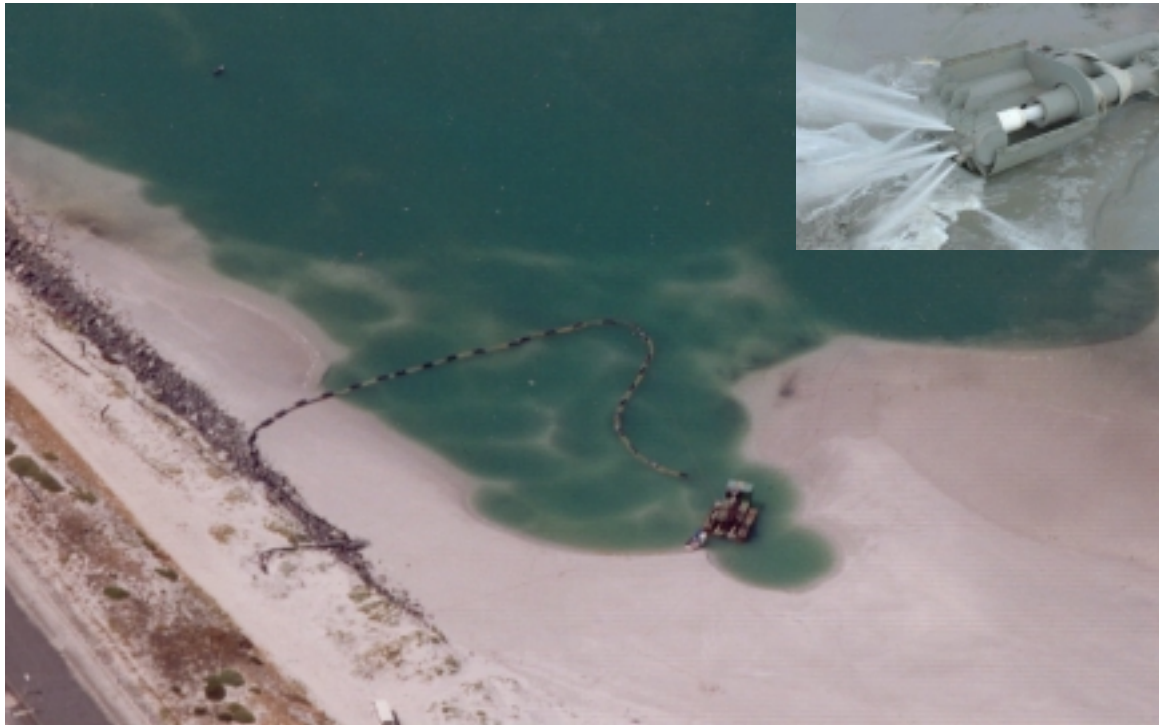
Figura 6: Jet pump y Dive Dredge en operación, Diciembre de 2002.
