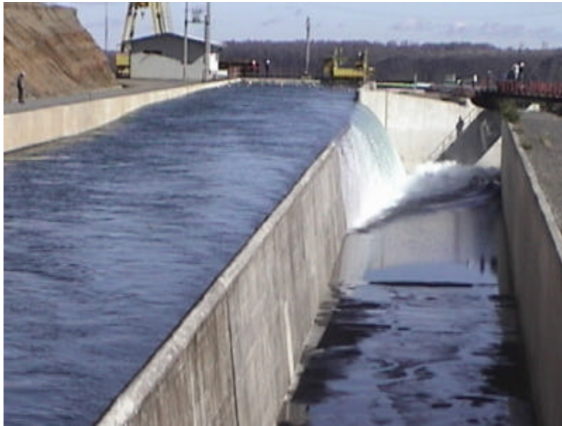
Foto 1 Frente de onda inicial en Cámara de Carga Central Rucúe
