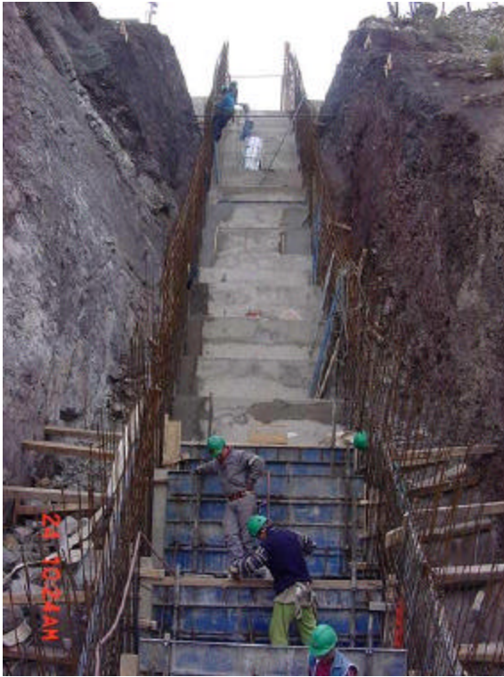
Foto 2 Construcción del rápido
