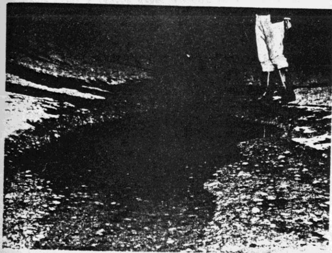
TUNEL N°2 Fotograffa N°4
