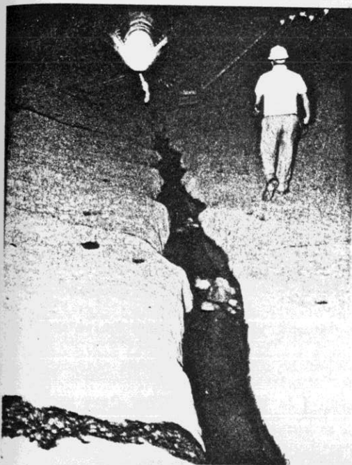
TUNEL N°1 Fotograffa N°3
