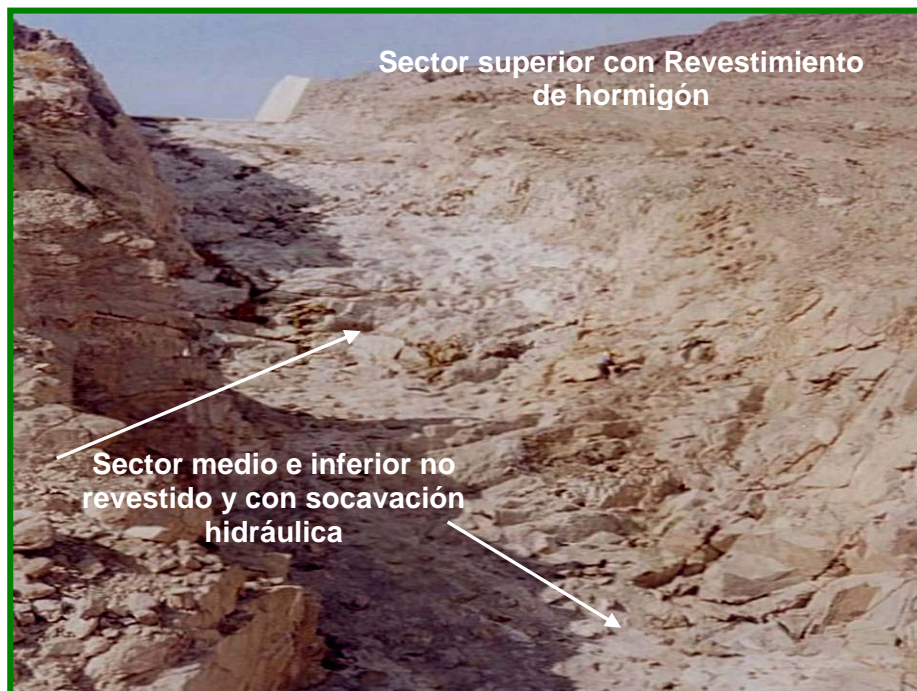
Rápido de descarga Vista desde aguas abajo
