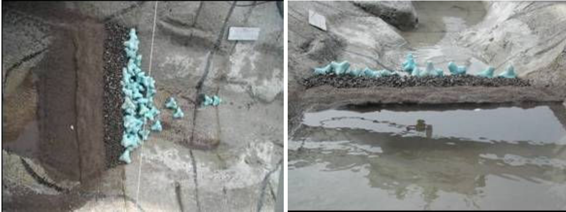
Figura 9: Vistas superior y desde aguas arriba de la preataguía en su situación final. Q = 600 \text{ m}^3/\text{s} y material de relleno grueso N° 2. Modelo Baker.
