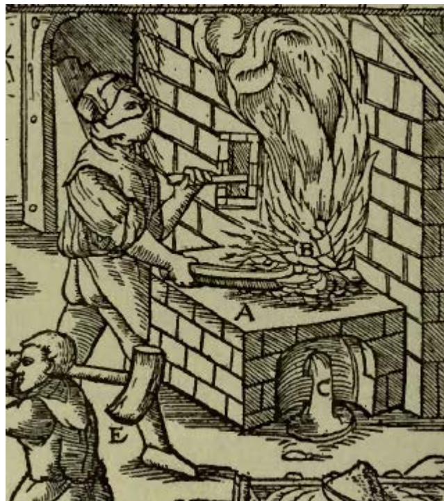
Figura 5. Operario en la fundición, con elementos de protección personal indicados por Agricola para protegerse del calor. Incluye gorra, máscara “con orificios para poder ver y respirar”, guantes y pecheras.
