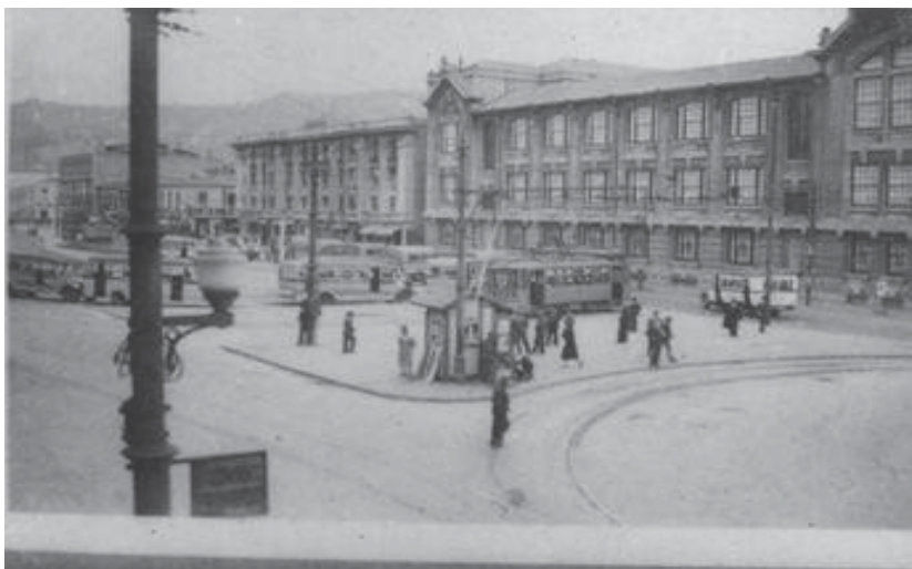
Avda. Argentina. Abovedamiento completo desde Santa Elena (1920)
