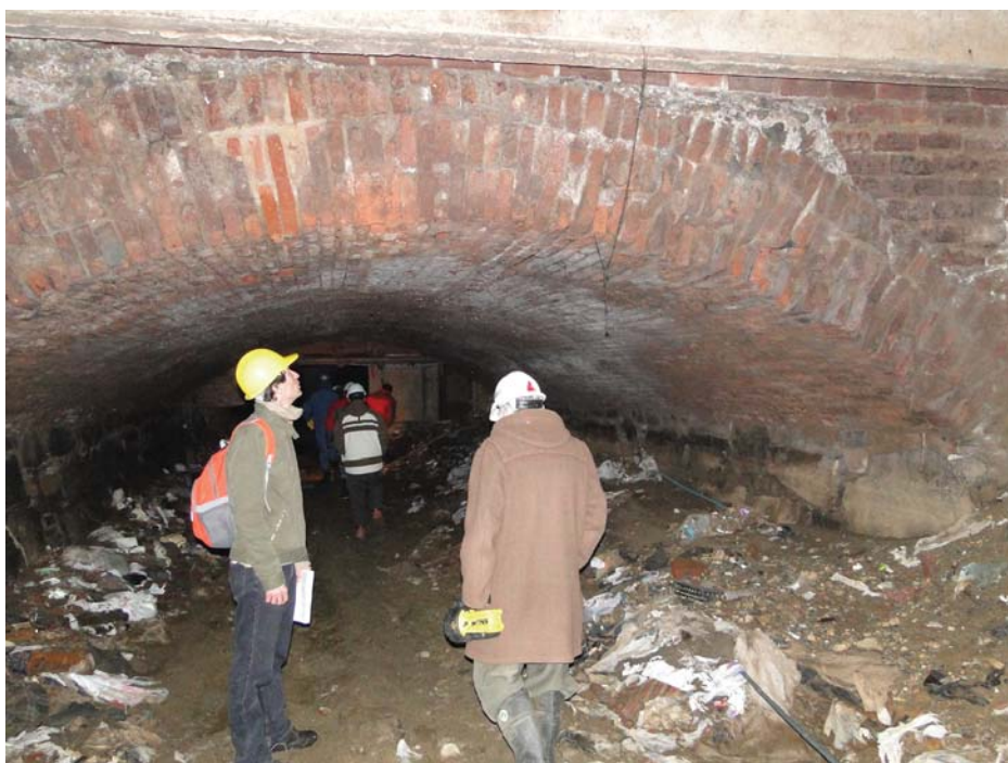
Puente de tres arcos bajo la losa del cauce en cruce avda. Brasil
