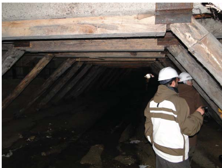
Reforzamiento interior mediante apuntalamiento de vigas de madera (Año 2007)
