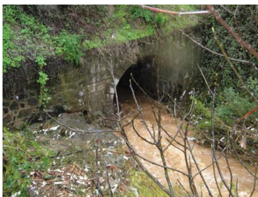
Túnel Cabrería de 4m. de diámetro
