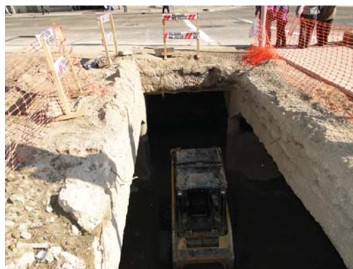
Accesos inadecuados para la limpieza periódica del cauce con maquinaria.
