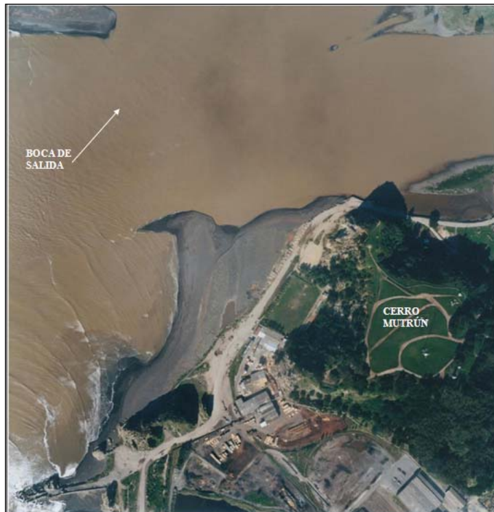
Figura 10.- Vista aérea de la boca de salida en bajamar (DOP, octubre de 1997).
