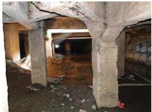
Obstáculos al flujo y al arrastre de sedimentos como tuberías, pilares desalineados.
