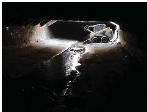
Accesos inadecuados para la limpieza periódica del cauce con maquinaria.
