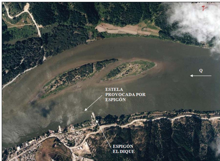
Figura 8.- Vista aérea de la isla del Perro y los espigones Fiscal y El Dique (DOP, noviembre de 1996).
