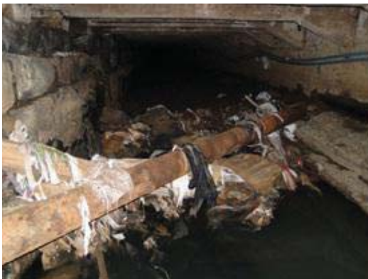
Obstáculos al flujo y al arrastre de sedimentos como tuberías, pilares desalineados.
